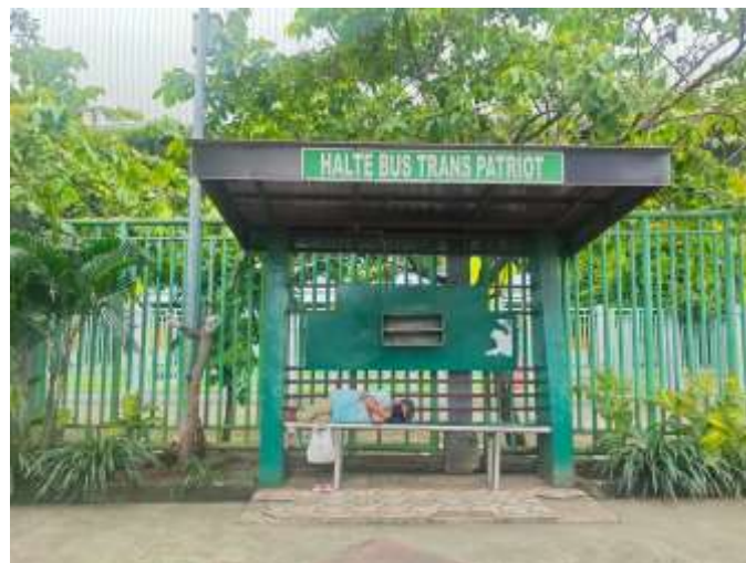
Gambar 4.2 Kondisi Eksisting Halte Bus Trans Patriot Sumber: (Survei Lapangan, 2026)
