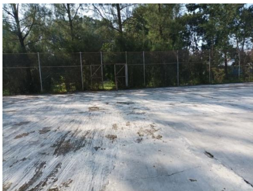
Gambar.1 Lapangan Sebelum Renovasi
